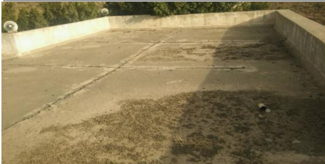
ARWA/ALFAOWZ SCHOOL Rooftop
